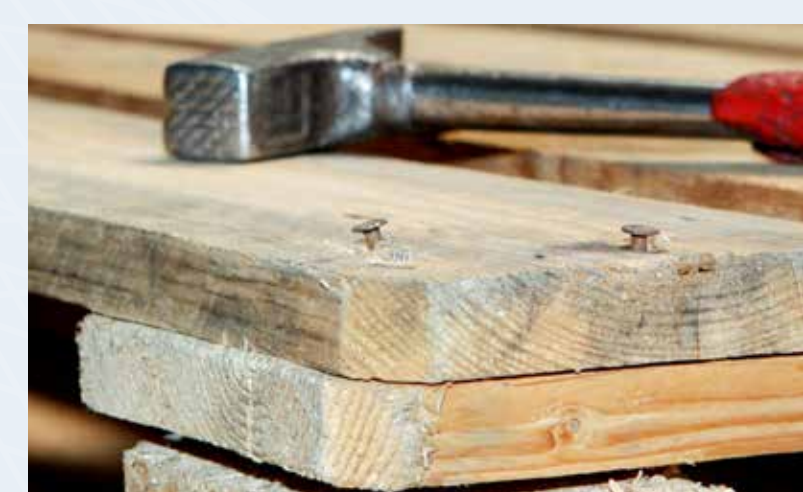
Einschlagen herausstehender Befestigungselemente
